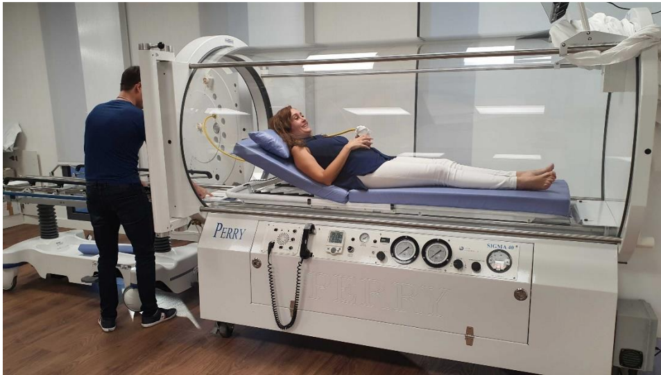
Figura.5 Painel de controle de Câmara Hiperbárica Monoplace.
